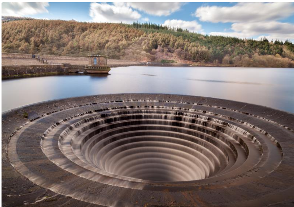
英格兰德比郡 Ladybower 水库的塞孔式溢洪口
