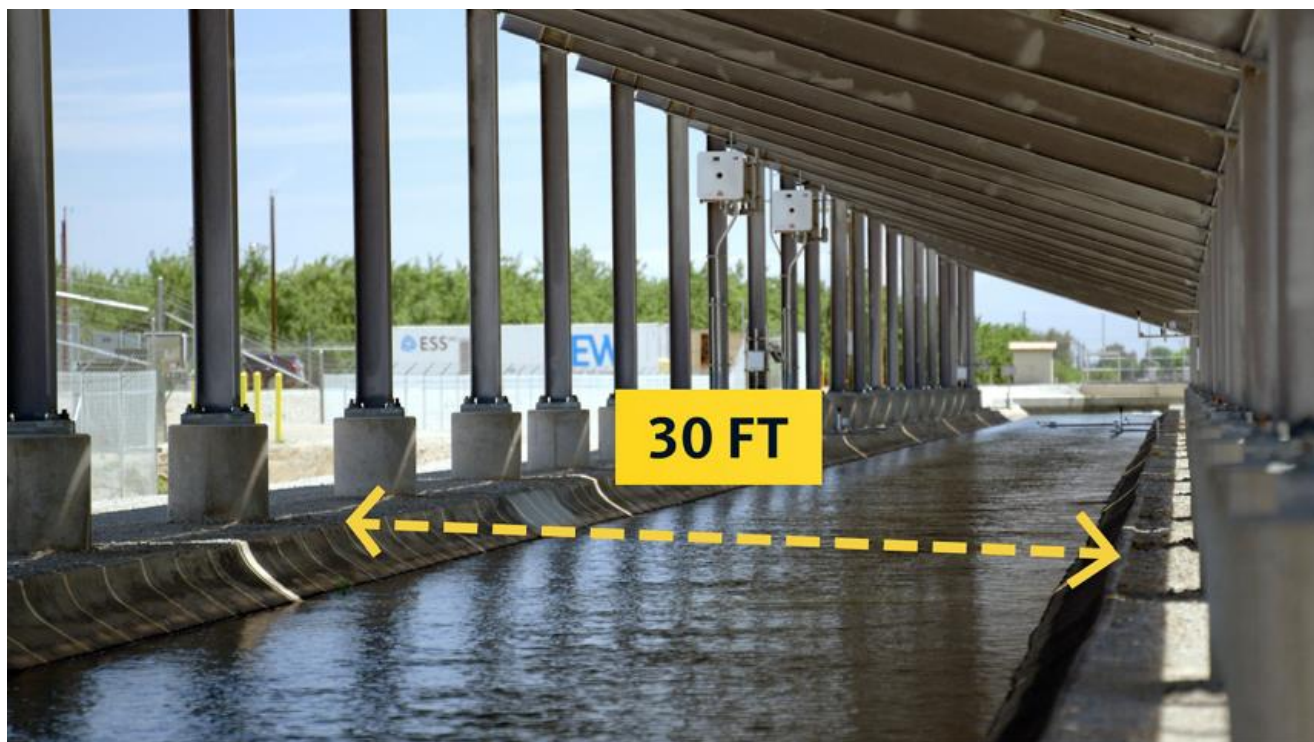
Nexus 项目正在一段运河上测试一组跨度为 30 英尺的太阳能板。图片来源：加州大学
