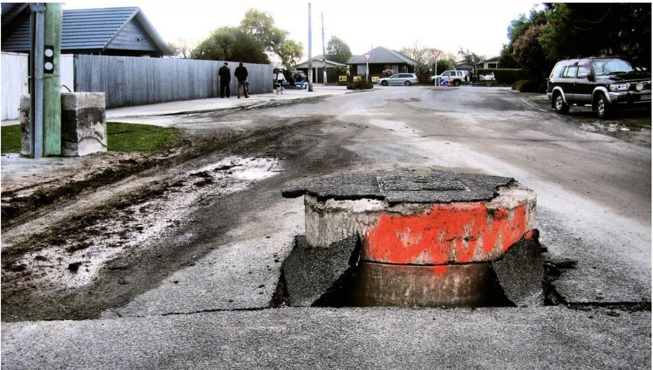
2010年新西兰坎特伯雷地震造成的土壤液化将街道上的雨水管道高高推出路面
