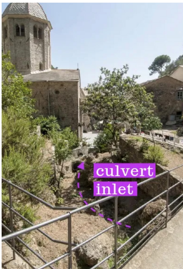
图 2.3 意大利项目区一处涵管接口
