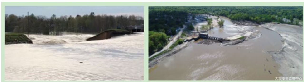
伊登维尔坝和桑福德坝溃坝后情况
