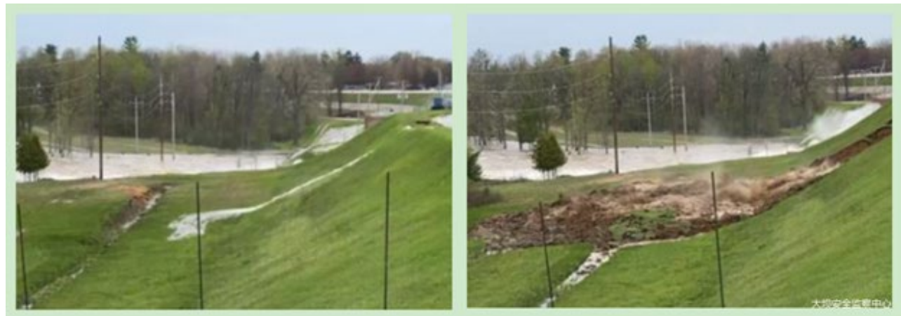
伊登维尔坝溃坝时刻和溃坝后 28s 的情况
