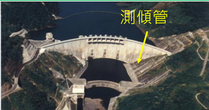
左壩座測傾管自動監測傳輸
